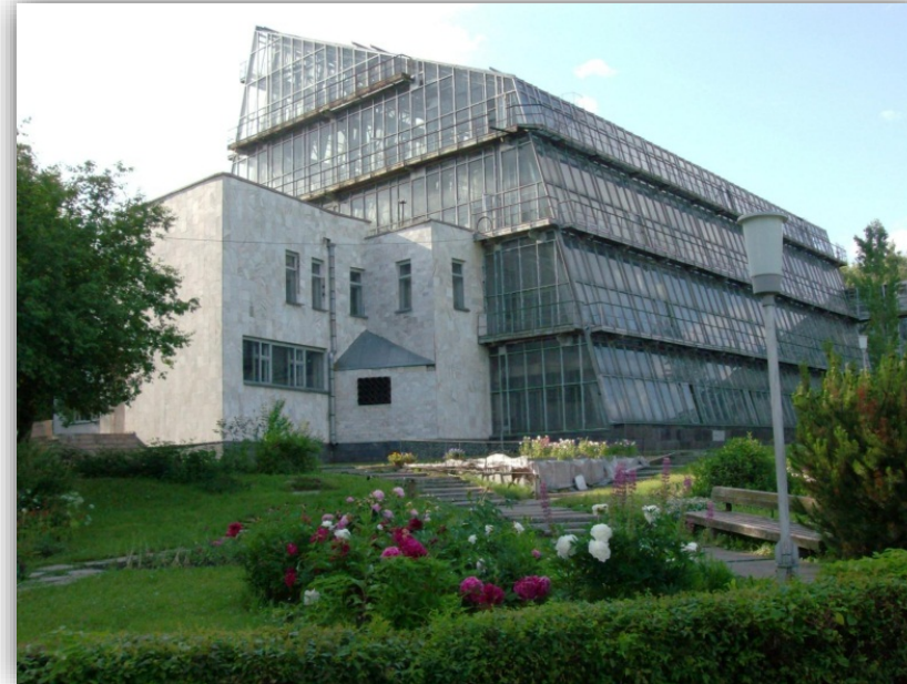
Уникальный для северных широт оранжерейно-тепличный комплекс площадью около 6 500 кв. м.
